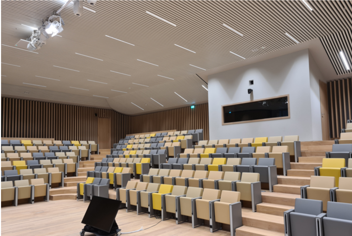
Hunter Douglas HeartFelt® 277 Stück L14-40-1134 mm mit Reflektor Xitanium DALI-Treiber mit GST18i5-Anschluss Sonderausführung RAL 9003 Lamellenhöhe 80 mm Geliefert über Wolfs Verlichting
